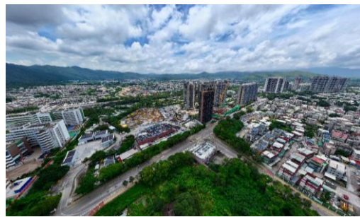
集团有两个位于北部都会区的大型住宅项目已经动工，并计划于2027财政年度推出市场。
