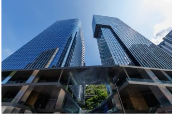
新世界九龍西雙子塔地標甲廈「83瓊林街」出租率約七成。
